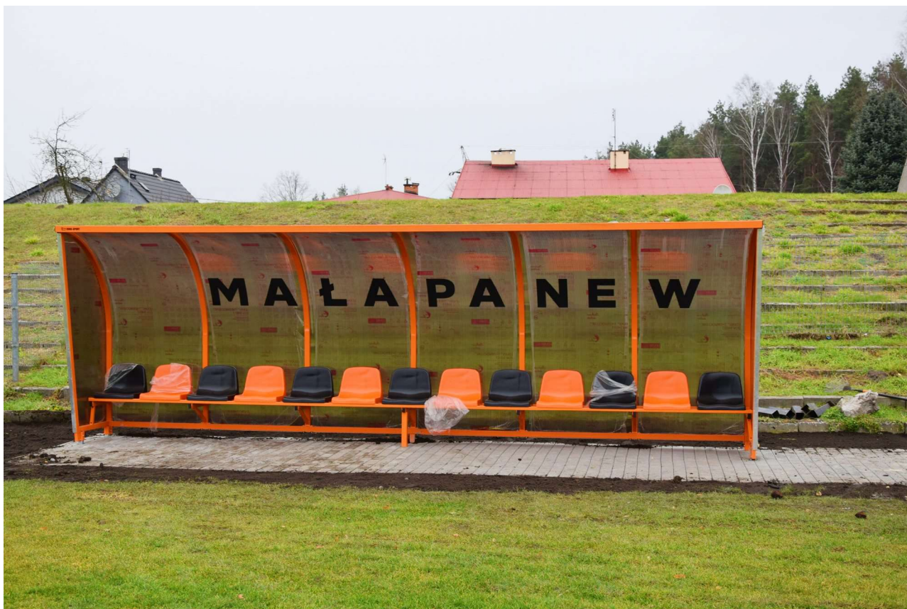
Montaż ławek rezerwowych na stadionie miejskim
