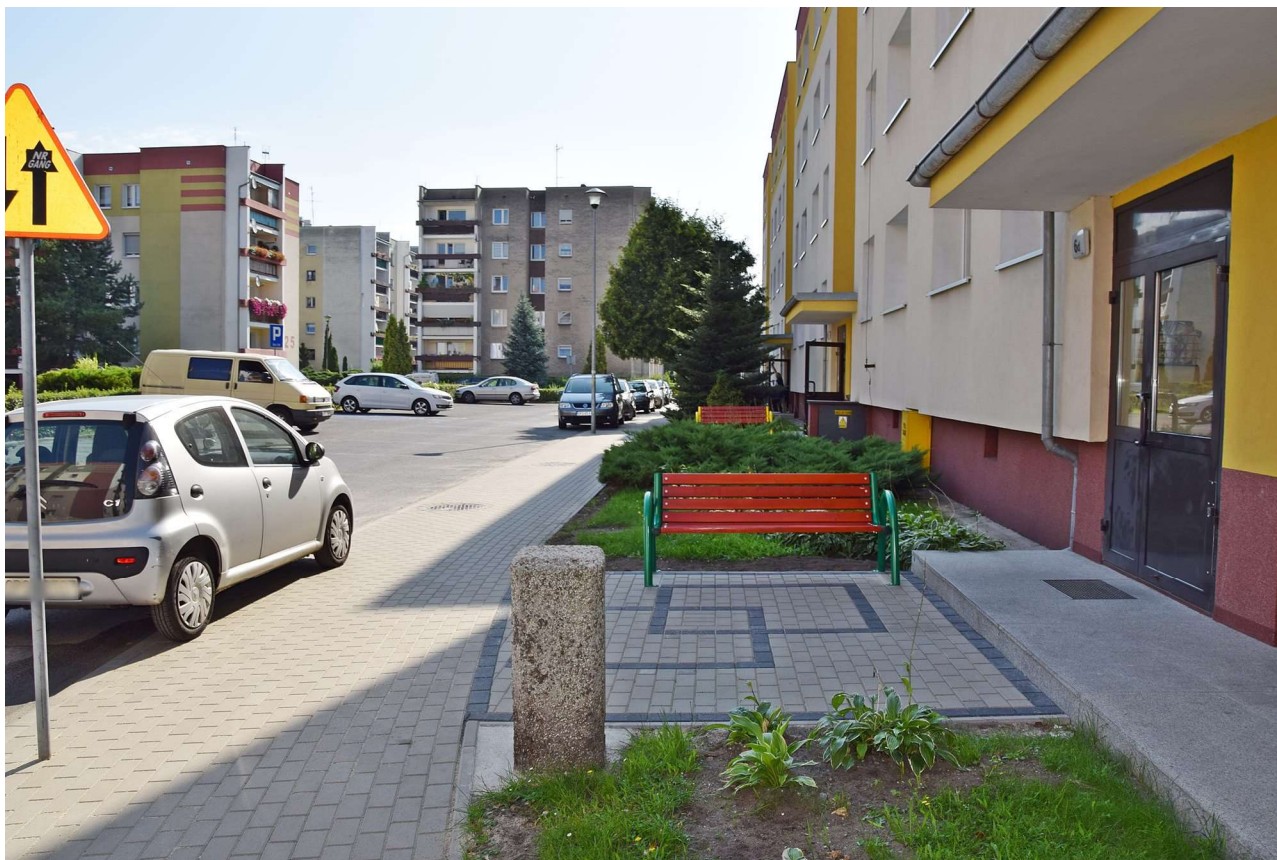
Remont chodnika wzdłuż budynku mieszkalnego przy ulicy Sikorskiego 6 a-d
